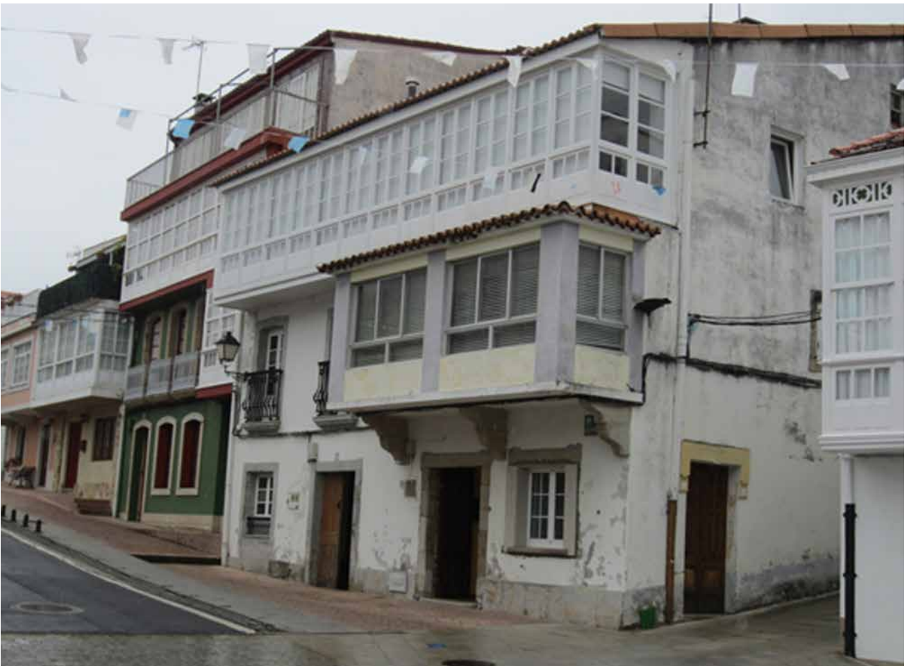
Ubicación do reloxo na fachada lateral do primeiro andar.
