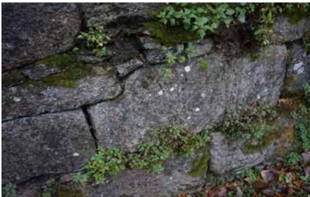
Muro da ponte da Cascada
