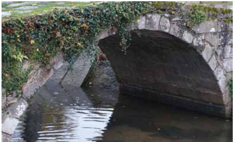
Fig. 2.- Detalle do arco da Ponte da Cascada
