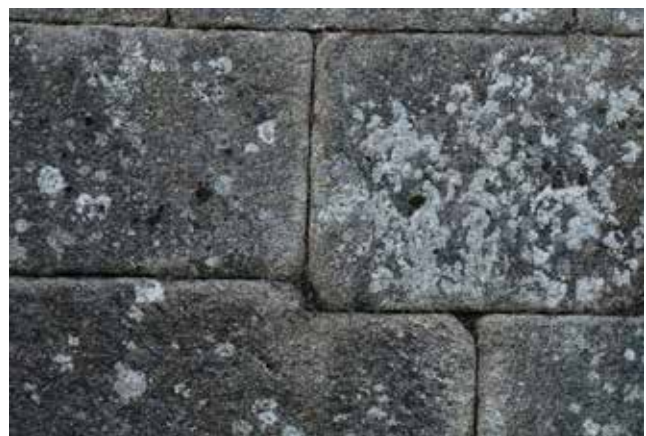
Muro do cemiterio de Canido
