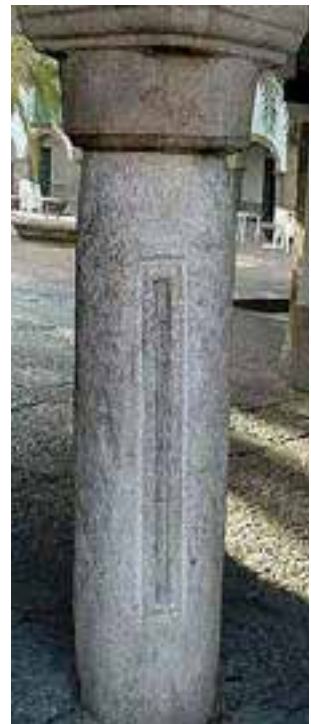
Fig. 5.- En el fuste de la columna que se encuentra en la plaza Chica del pueblo de Zafra (Extramadura) se labró en el siglo XV una unidad de longitud que se llama la VARA DE ZAFRA, para ser utilizada por los compradores y comerciantes establecidos en la plaza, a veces como patrón y otras para medir directamente los géneros.
