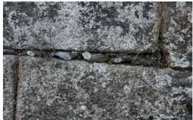
Muro do cemiterio de Canido
