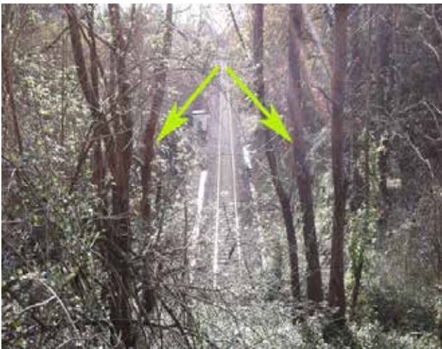
A.- Entrada del camino Real en Caamouco por delante del túnel de Franca. La vía del tren lo cruza. Arch. Naveiras.
