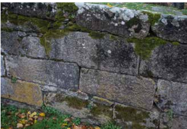
Muro da ponte da Cascada
