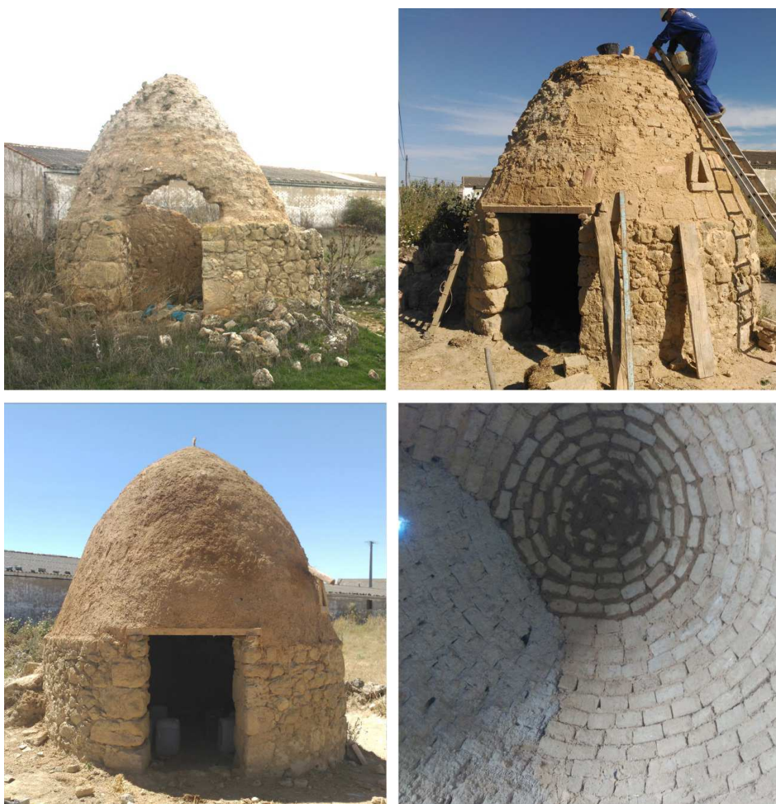
Fig. 6. Diferentes estados de chozo en Urueña (Valladolid) donde se realizó una intervención entre Abril y Junio de 2016 para recuperar sus muros de piedra y cúpula de adobes. Parte de los trabajos se realizaron con un Taller Experimental con más de 30 alumnos, maestros locales y docentes universitarios.
