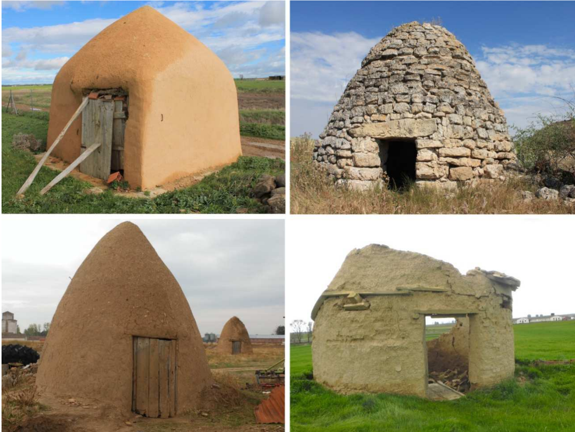
Fig. 2. Ejemplos de chozos en el corazón de la Vieja Castilla. En la imagen superior izquierda un caso tipo de caseta de era en Tierra de Campos en Quintanilla del Monte (Zamora – Marzo 2016); hacia la derecha en la franja superior se aprecia un chozo de pastor en Dueñas (Palencia – Abril 2015); en la línea inferior a la izquierda dos casos de cúpula con arranque desde el suelo en Torrecilla de la Abadesa (Valladolid – Octubre 2016); y a la derecha una caseta de planta circular con la cúpula en ruinas en Villalón de Campos (Valladolid – Marzo 2013). Fuente: Oscar Abril Revuelta.
